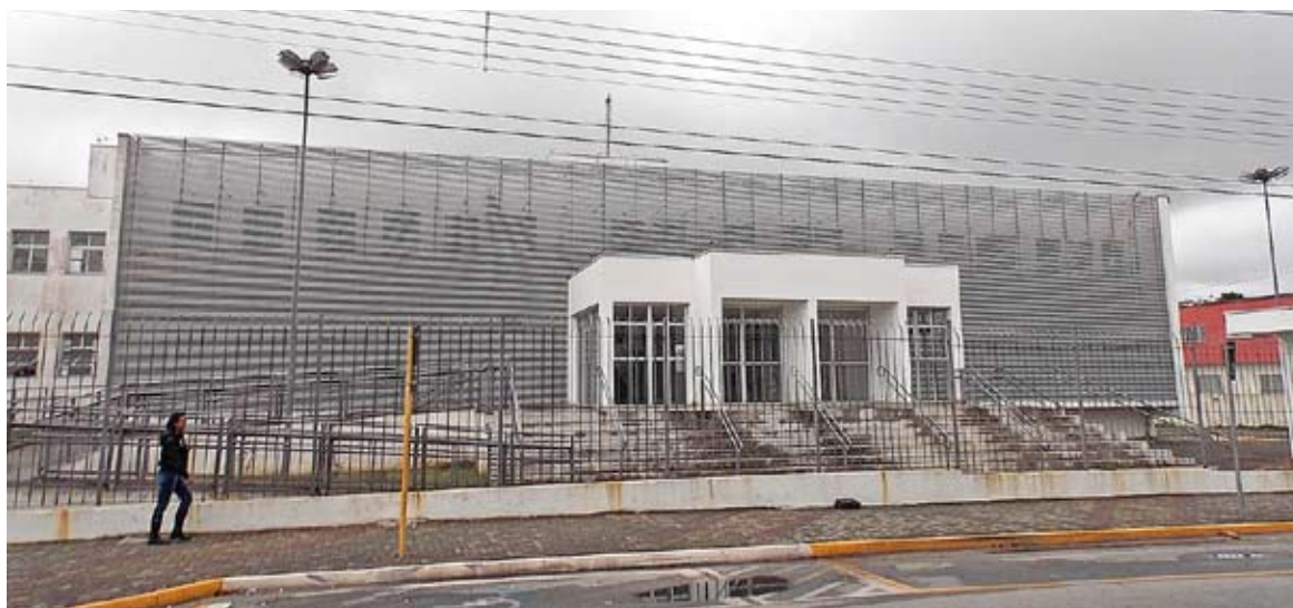
O novo prédio do Fórum da Comarca de Itanhaém, pronto para uso desde setembro de 2013, começou a ser ocupado somente agora no mês de agosto
